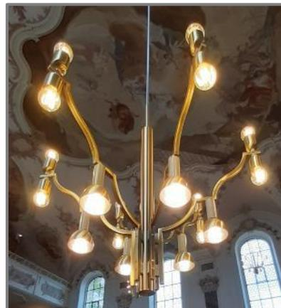
Umstellung bei **1 Kronleuchter** von Glühbirnen (75W) auf dimmbare LED-Filamentleuchten gleicher Bauform (9 W, warmweiß). Der **Energieverbrauch eines Kronleuchters** mit je 18 Einzelbirnen **sinkt um 88%** (von 1300 W auf 155 W).
