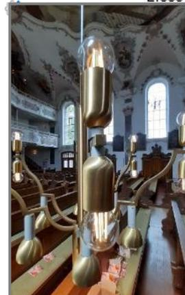
Nächster Schritt ist weitgehende Umstellung von Glühbirnen auf LED-Lampen in der Kirche. Dann sinkt der Stromverbrauch um ca. 80%. Strombedarf lässt sich dann >90% mit PV decken!
